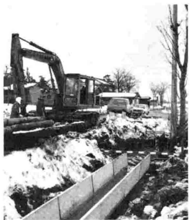
▲西小川江用水路工事風景
