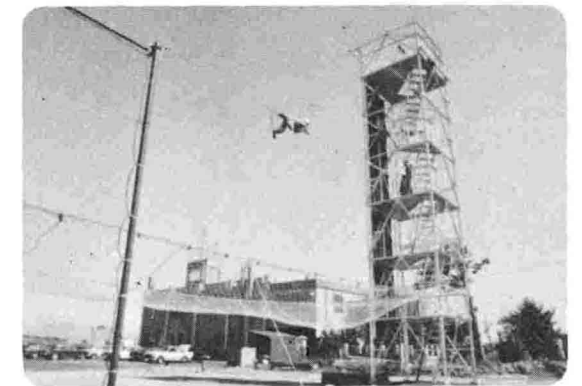
▲与板郷消防署では、高層ビルの火災や山での遭難事故などに万全を期すため、このたび救助訓練塔を新設。連日若手職員がこの塔を利用して渡過訓練、登はん訓練、降下訓練を繰り返し、万一の事故に備えています。
