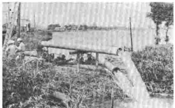
押切思川地区の排水作業
