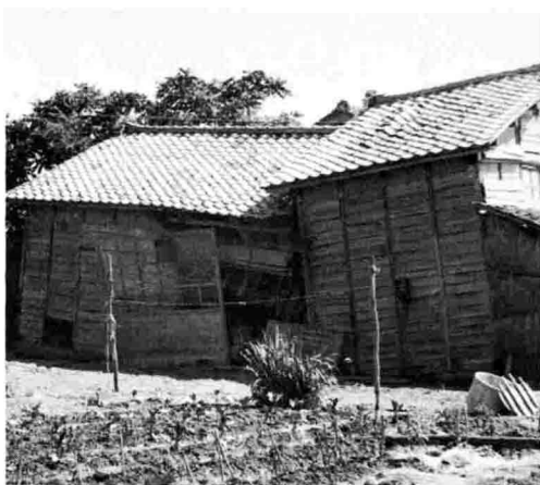
地震で傾いた作業所
