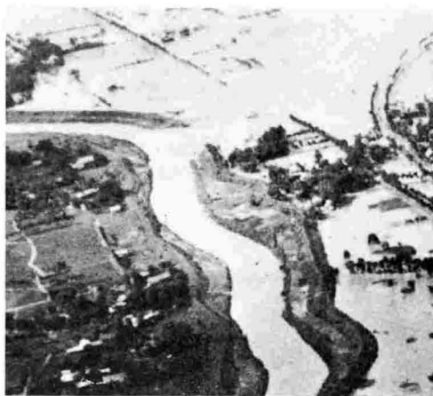
破堤の様子 (航空写真)
