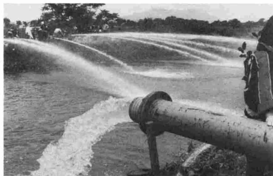
▶消防ポンプ十六台合わせて四十台で排水作業
