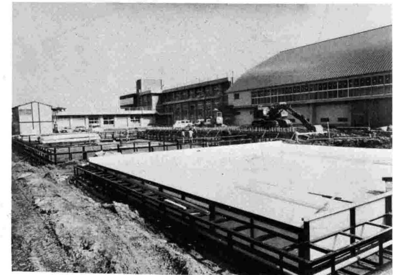
中央小のプール工事も急ピッチで……
