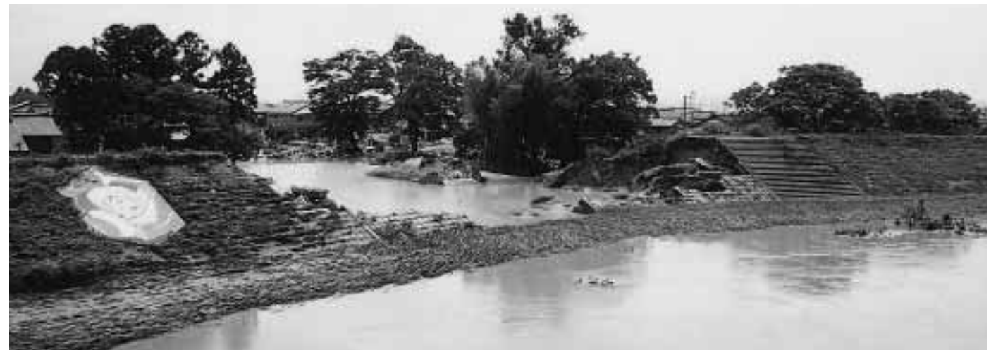
破堤した刈谷田川
