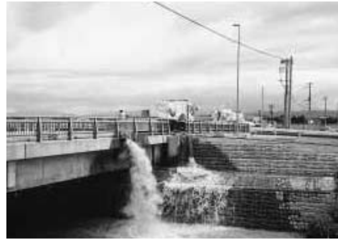
三沼地区の排水作業
