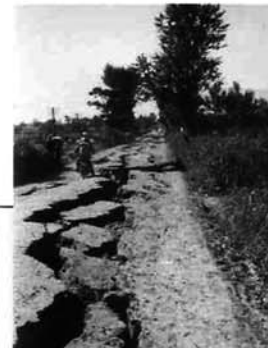
新潟地震でひび割れた道路。
