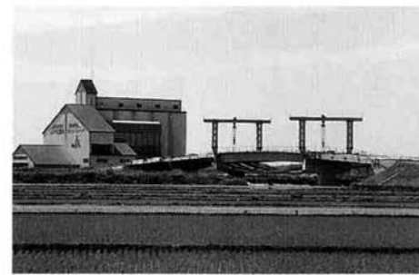
建設中のカントリー大橋
