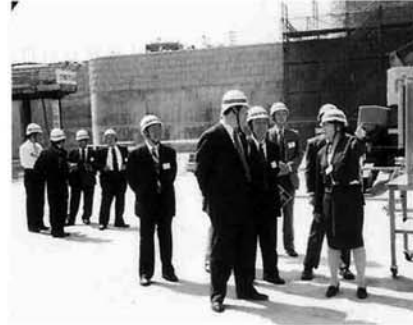
▲大河津分水洗堰新築工事現場。
