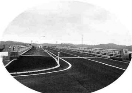
完成した並木橋
