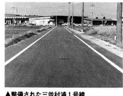
▲整備された三並村浦1号線（中之島住宅団地内）
