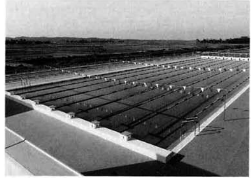
▲完成した中之島中学校プール
