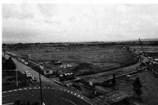
造成中の流通団地
