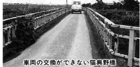
車両の交換ができない猫興野橋
