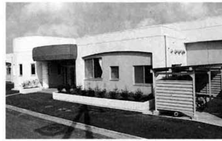
竣工なった 上通保育所
