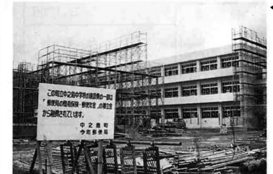
建設が進む 統合中学校
