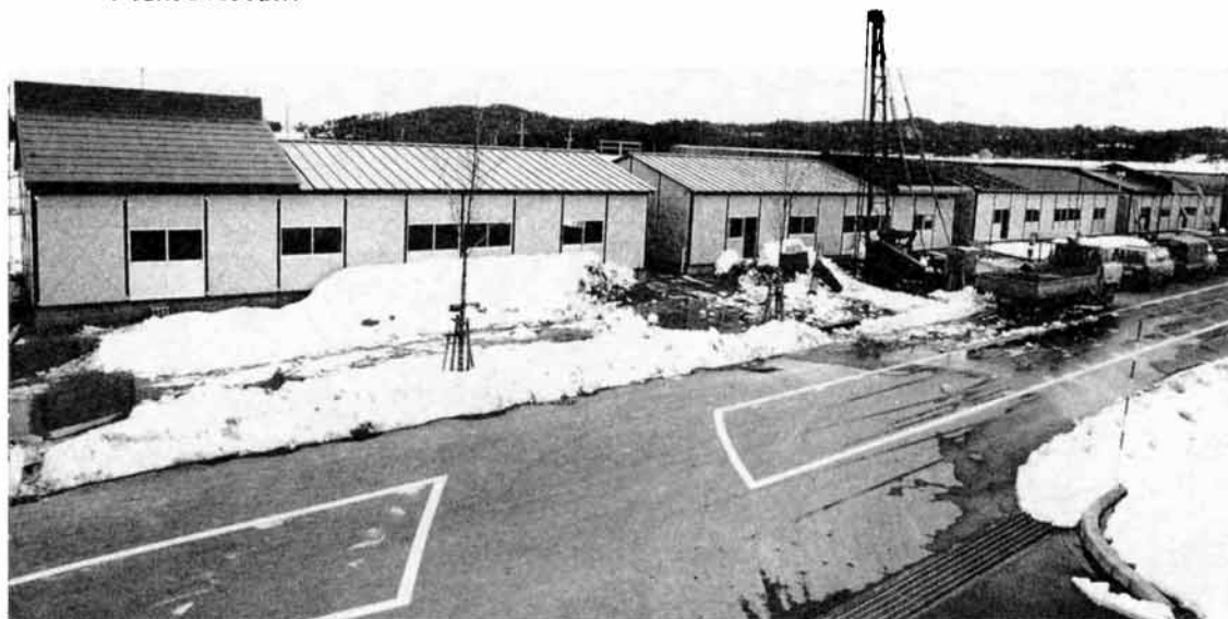
▼完成した実験棟
