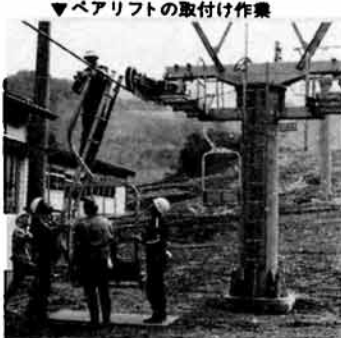
▼ペアリフトの取付け作業
