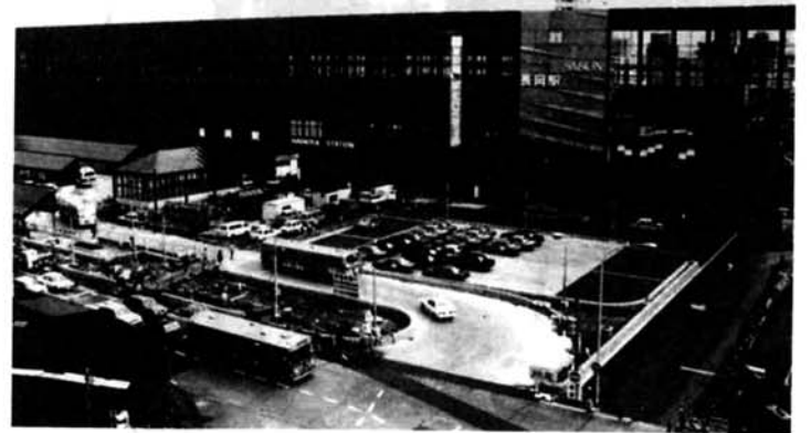
完成間近な大手口駅前広場
