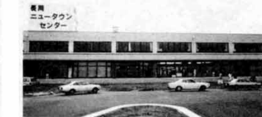
▲まちの魅力をつくる核として建設した長岡ニュータウンセンタービル。
