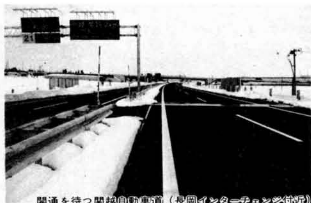
開通を待つ関越自動車道(長岡インターチェンジ付近)
