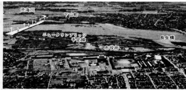
仮称「ニュータウンブリッジ」架設場所
