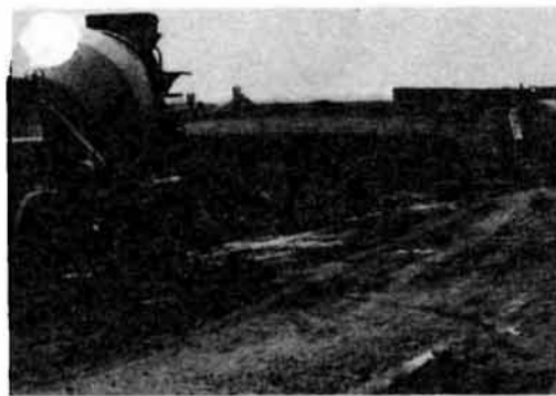
▲昨年から建設が始まった右岸取付道路(大手大橋)
