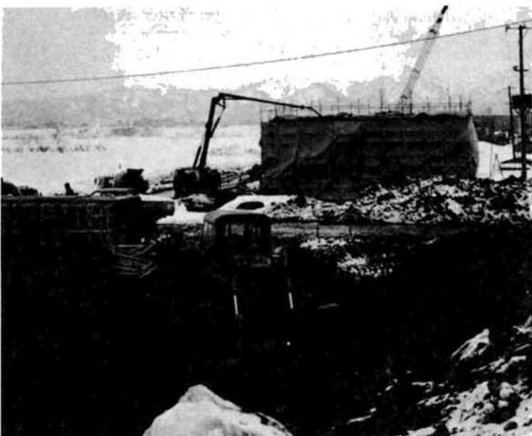
▲冬期間も順調に進む大手大橋建設工事
