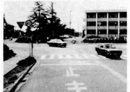
大手大橋右岸の取付道路用地、裁判所(右上)も間もなく移転します。
