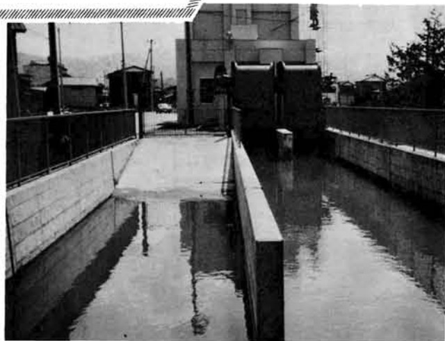
▶山北用水揚水機場
