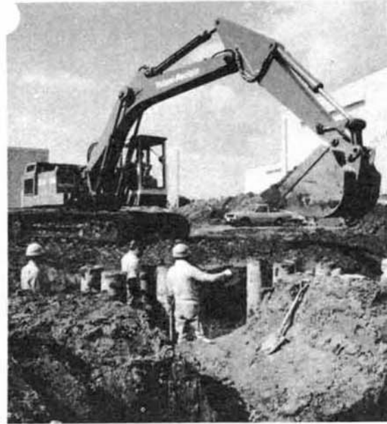
▲建設の始まった裁判所新庁舎
