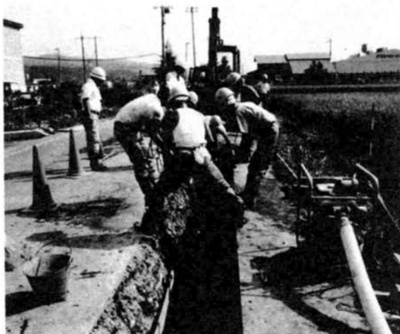
配水管敷設工事
