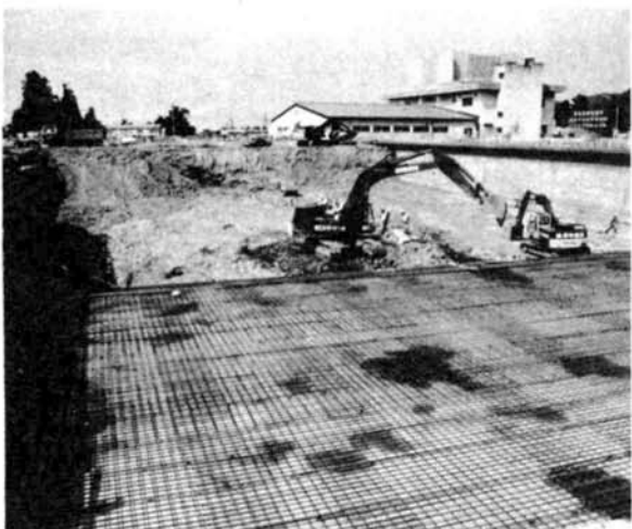
妙見浄水場の拡張工事
