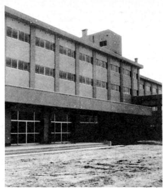
建設進む長岡商業高校
