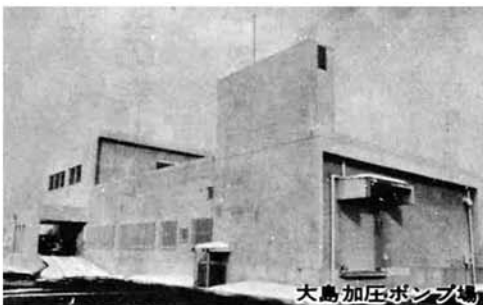
大島加圧ポンプ場
