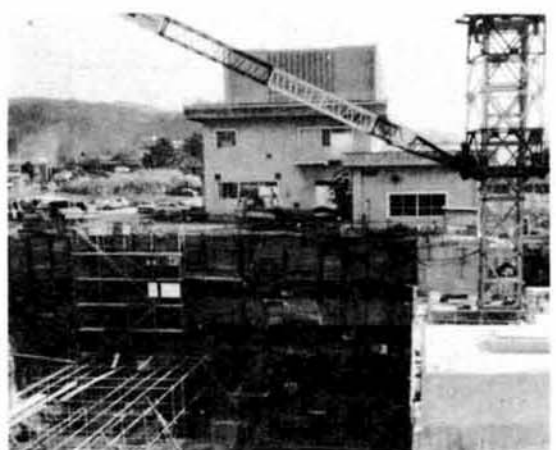
妙見浄水場では、3,300トン収容の浄水池2池の工事が急ピッチで進んでいます。
