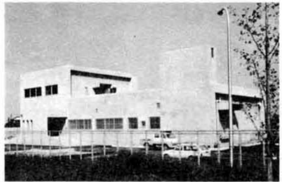
ポンプ設備3台と自家発電装置などが取り付けられ、整備を完了した大島加圧ポンプ場。
