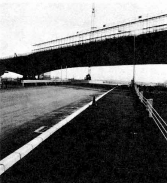
上は上越新幹線太田川橋りょう(豊詰町)
