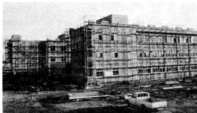
希望が丘小学校の新築
