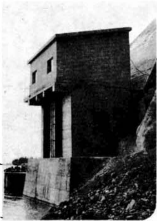
1日12万トンの取水能力をもつ 取水口 (昭和46年完成)
