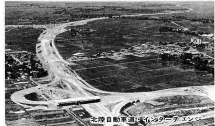
▲陸の港—長岡インターチェンジ 延々として続く盛土のライン...北陸自動車道—石動町地内の長岡インターチェンジもトランペット型の姿をはっきり見せています。
