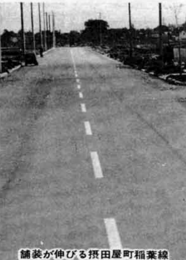
舗装が伸びる撰田屋町稲葉線
