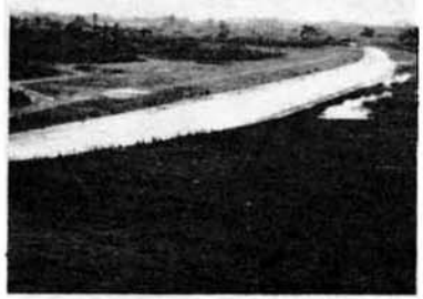
低水路工事が進む信濃川
