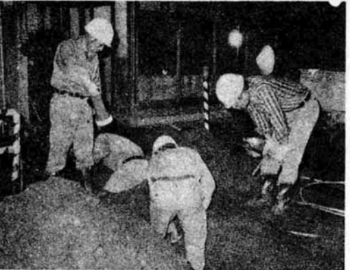
【水道管の破損修理 夜10時 寿地内で...】
