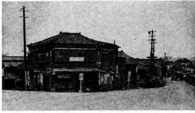
(写真②整理後の長生橋西詰附近①同整理前)
