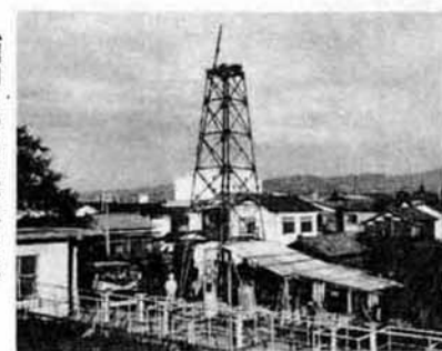
〔掘削中の深層部観測井〕
