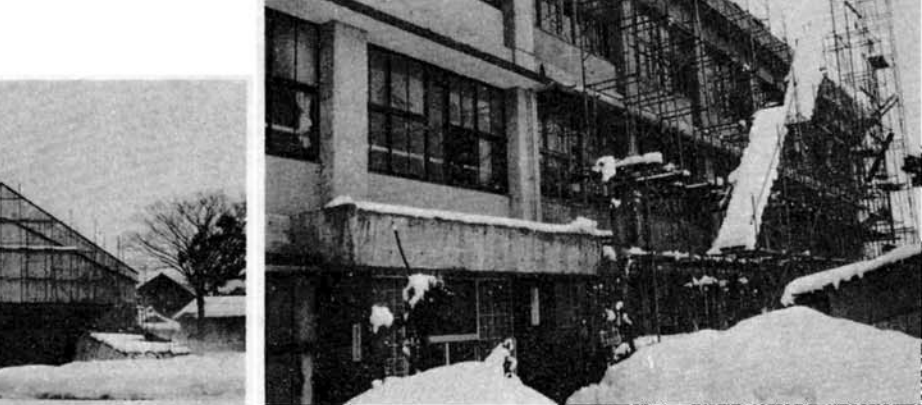
●上川西小学校改築工事（二期工事） 鉄筋三階建 一、一九七平方メートル 普通教室 6室 管理諸室 6室 給食室 1室 昇降口 1室 昭和43年度工事費 3、860万円 竣工予定 3月25日
