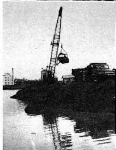
改修中の栖吉川—地蔵町地内—
