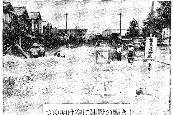
つゆ明け空に建設の響き 「つゆ明け空に建設の響き」。夏の到来とともに、下水道の建設現場も活況を呈している。建設現場からは、機械の音や作業員の声、そして夏の空気が感じられる。
