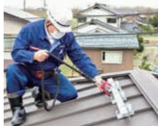
▶命綱固定アンカーの設置作業
