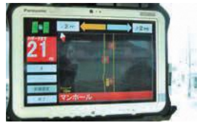
▲経験の浅い運転員の作業を支援する音声ガイダンス装置
