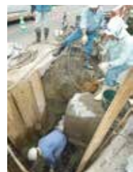
▲震災時の水道復旧現場
