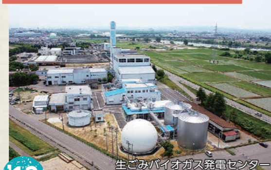
生ごみバイオガス発電センター
