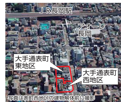
写真は表町西地区の建物解体前に撮影
