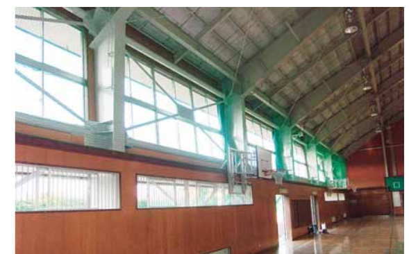
耐震補強を終えた中島小学校体育館。平成27年度までに全ての小・中学校で補強工事を完了します。
