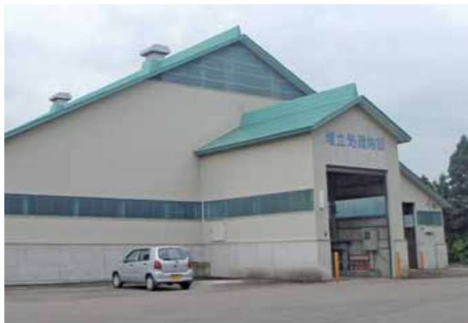
▲栃尾最終処分場。屋根が付き、コンクリートで周囲を囲んだ密閉型の施設
