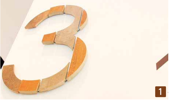
1 総合窓口の案内表示は厚生会館の床材を再利用(東棟1階) 2 市民が集うホワイエの壁は小国和紙。後ろからの光がやわらかく空間を照らす(西棟1階) 3 ナカドマから続く1階の床は土に似た質感。奥に見える総合窓口カウンターの枋尾紬との調和が美しい 4 巨大な扉を開けるとアリーナとナカドマはつながったひとつの空間に
