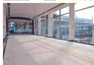
工事中の歩道。幅4mの広い歩道は、両側ガラス張りです。開放感があります。
