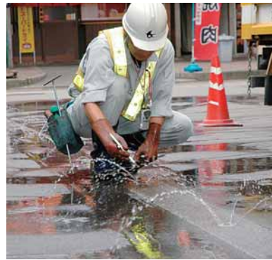
▲毎年10月から行われる消雪パイプの点検作業は季節の風物詩(坂之上町1)
