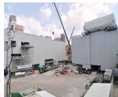
▲8月4日現在の建設現場
